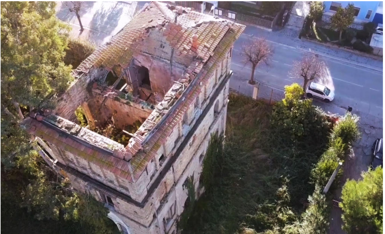
VISTA DEL TORRINO LATO NORD EST
